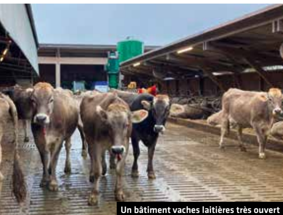
Un bâtiment vaches laitières très ouvert
